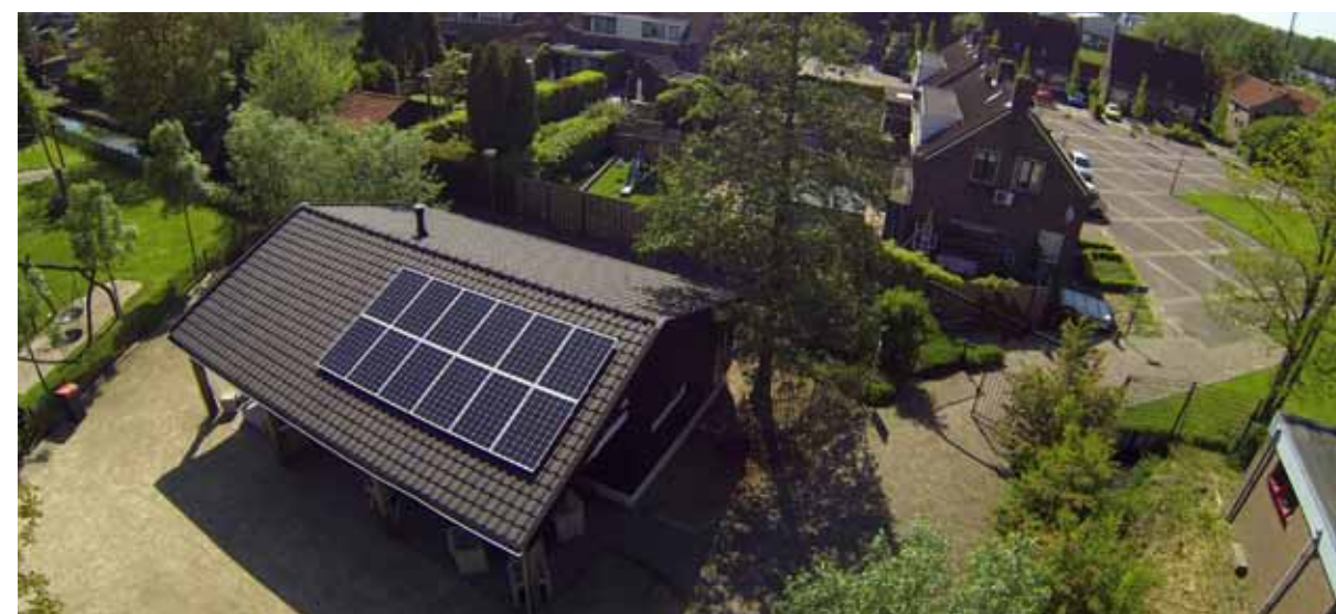
De zonnepanelen op het dak bij gebouw van Het Weitje
